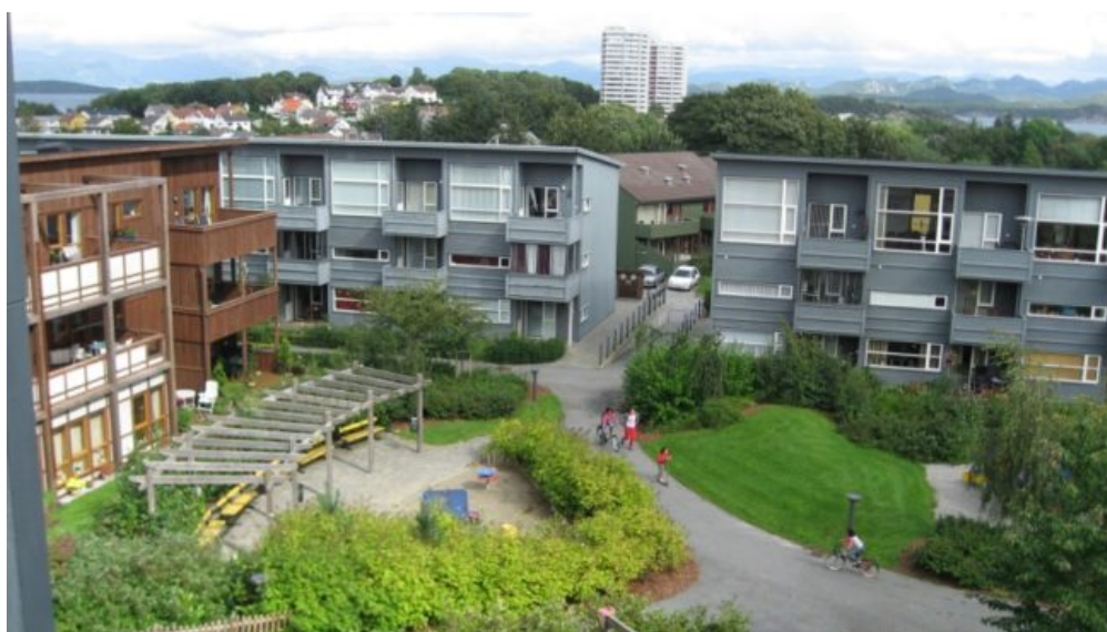
Figur 6: Gode utearealer for lek/opphold og snarveier gjennom kvartalet. Prosjektet har tilført bydelen et nytt større uteareal for lek og opphold på et tidligere industriareal. Spikerfabrikken, Stavanger. Kilde: Guttu, Schmidt 2008.
