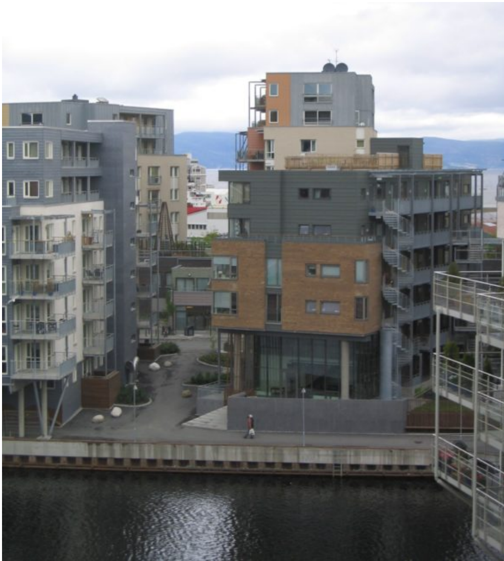
Figur 2: Fortetting og høy utnyttelse kan resultere i trange og mørke utearealer, slagskygge på plasser, boliger med dårlige sol- og lysforhold, og problem med innsyn i boligen. Illustrasjon: Boliger på Nedre Elvehavn, Trondheim. Kilde: Guttu, Schmidt 2008.
