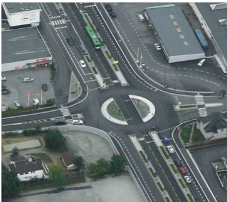
Figur 8: Rundkjøring på fv. 44 ved Hillevåg i Stavanger. Foto: Rapport 312 (SVV 2014b).
