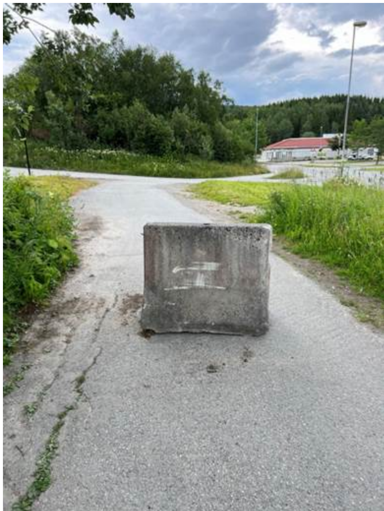
Figur 7: Gang og sykkelvei med jerseystein uten refleksmarkering. Foto: Anastasiia Kolesnikova
