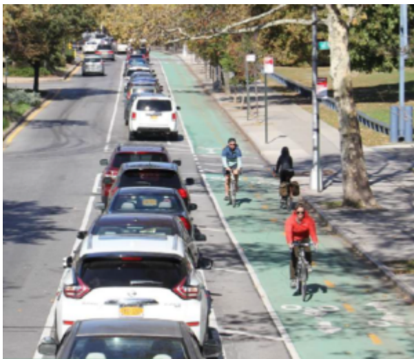
Beskyttet sykkelfelt, med parkerte biler som beskyttelse. Queens, NY. (det er plass nok mellom bilene og sykkelfeltet til at dørene kan åpnes uten å treffe syklistene). Photo: NYC Department of Transportation.
