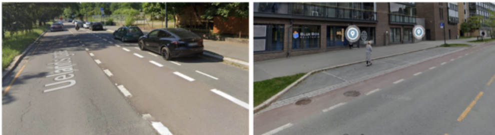
Figur 10: Sykkelfelt langs gateparkering (Oslo, Uelands gate til venstre; Trondheim, Stadsing Dahls gate til høyre). Kilde: Google Maps, Streetview.
