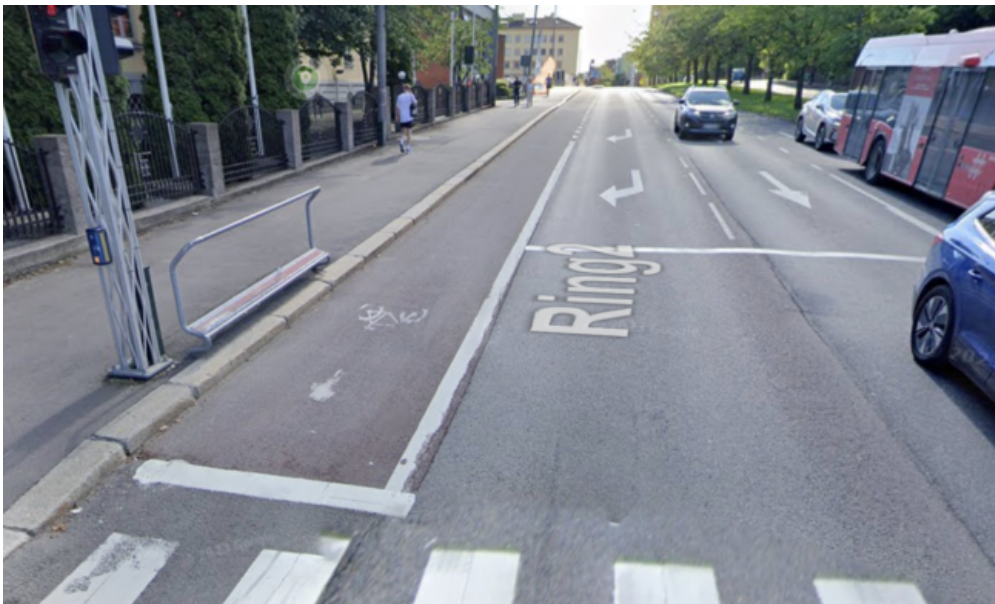
Figur 9: Tilbaketrukket stopplinje på kjørefelt (Oslo - Ring 2). Kilde: Google Maps, Streetview.
