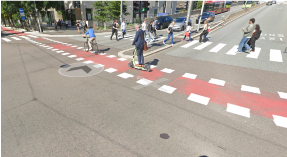
Figur 1: Et eksempel på den begrensede levetiden til et farget dekke (Oslo, Dronning Eufemias gate) Kilde: Google Maps, Streetview.
