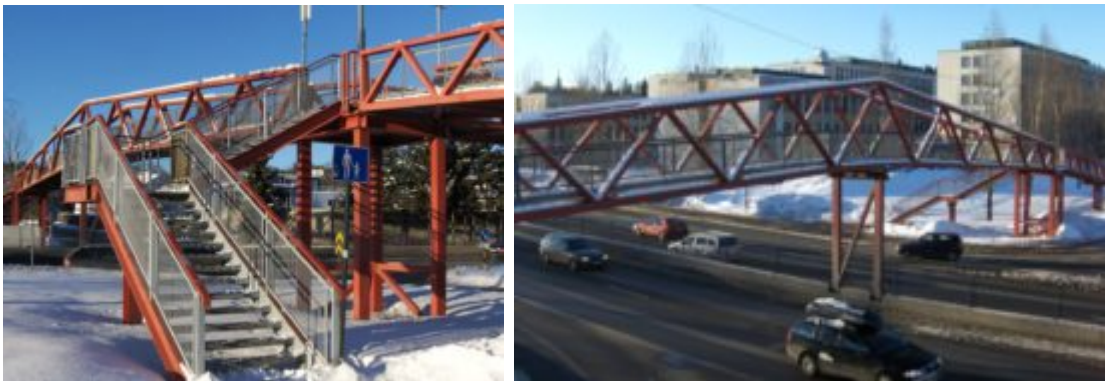
Figur 4: Gangbru over Ring 3 i Oslo (Foto: M. Sørensen).
