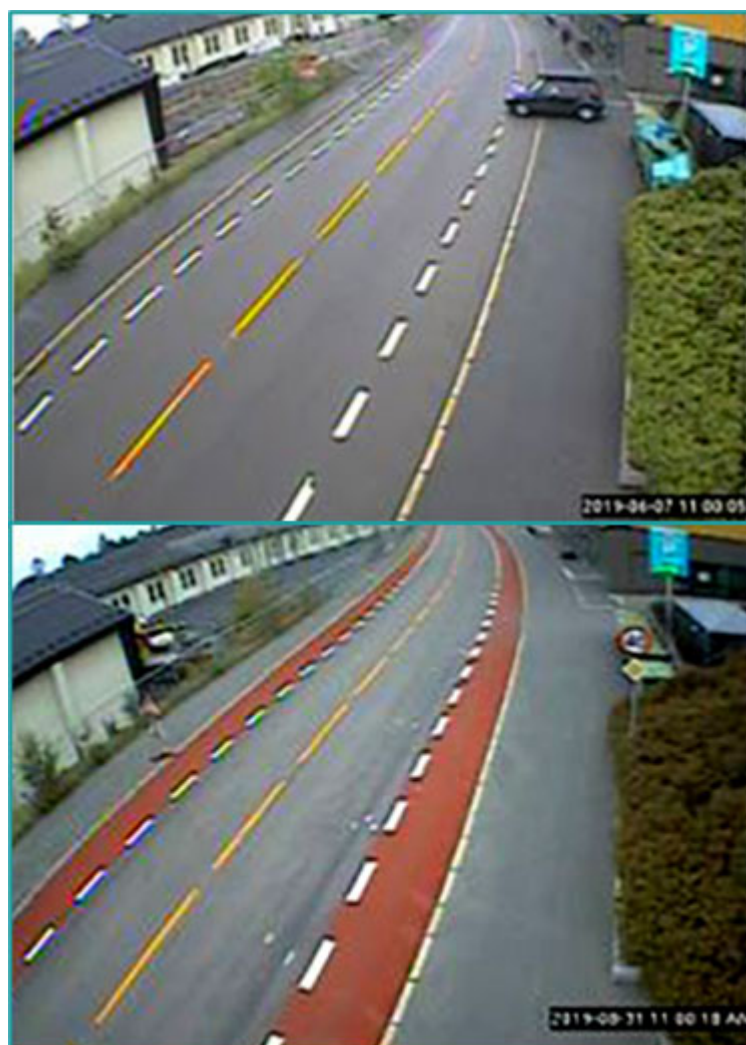
Figur 5: Kongsveien i Oslo før og etter rød asfalt. Kilde: Fyhri et al. 2021
