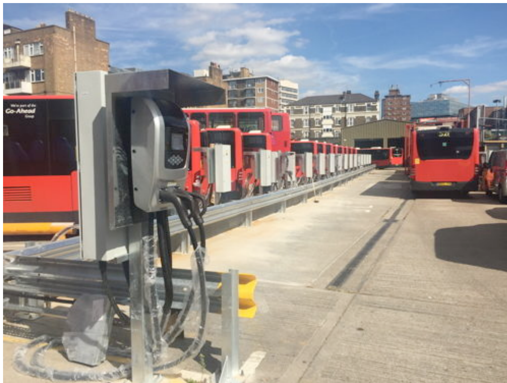
Figur 1: Anlegg for depotlading av 46 elbusser ved Waterloo bussdepot i London. Bilde: Zap Map.
