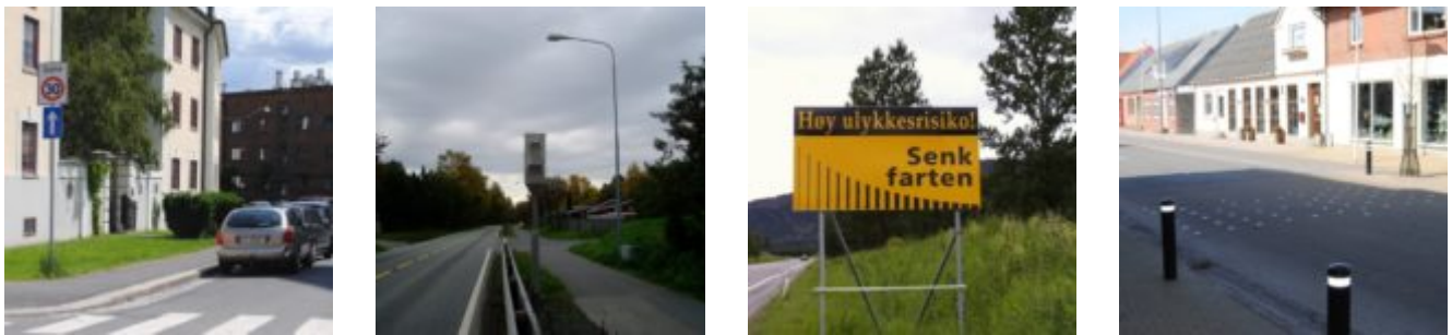
Figur 5: Eksempel på ikke fysisk fartsdempende tiltak; skilting av fartsgrense, automatisk trafikkontroll, informasjonsskilt i vegkanten og pullerter. Foto: M. Sørensen.
