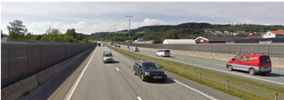
Eksempel på støyskjerm langs en høy trafikkert veg (E18). Skjermen ligger tett til støykilden og må tåle belastning av salt, snø og påkjørsel. Den rette linjeføringen i toppen bidrar til at den er underordnet landskapet. Foto: Ingvil H. Hoftun.
