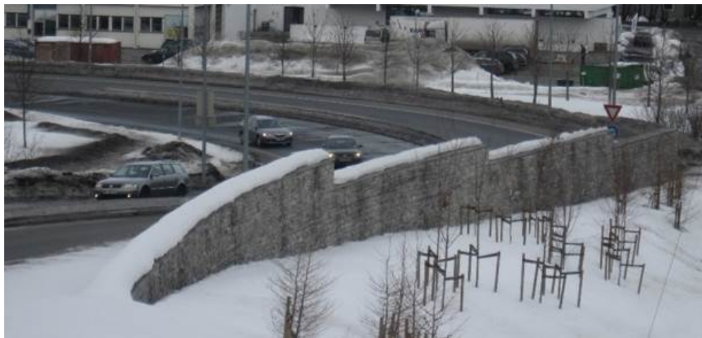
Støyskjerm som består av en betongkjerne med forblending av vrakskifer. Skjermene er robuste og tåler belastning av vegtrafikken. Foto: Ingvil H. Hoftun.
