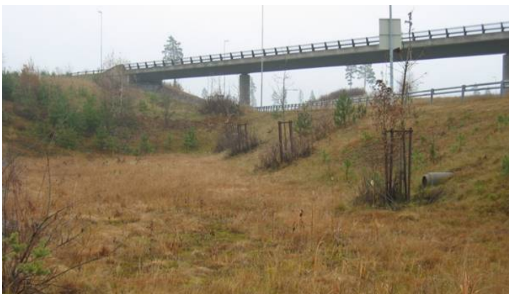
Figur 4: Infiltrasjons-/filterbasseng langs hovedveg (trinn 1+2 rensing). Innløpet ligger til høyre i bildet (Foto: Svein Ole Åstebøl, COWI AS).
